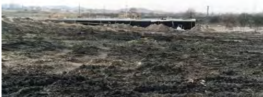
Teren budowy Kompleksu Nauk Biologicznych; kwiecień 2000
