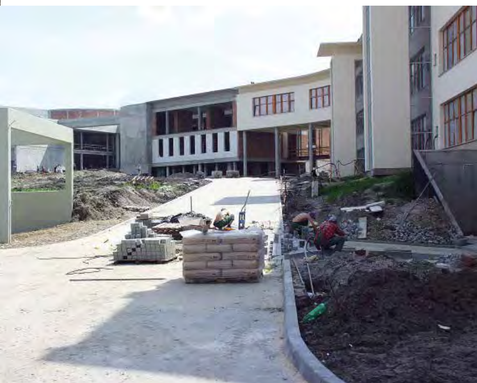
Dziedziniec Kompleksu Nauk Biologicznych w budowie; czerwiec 2001
