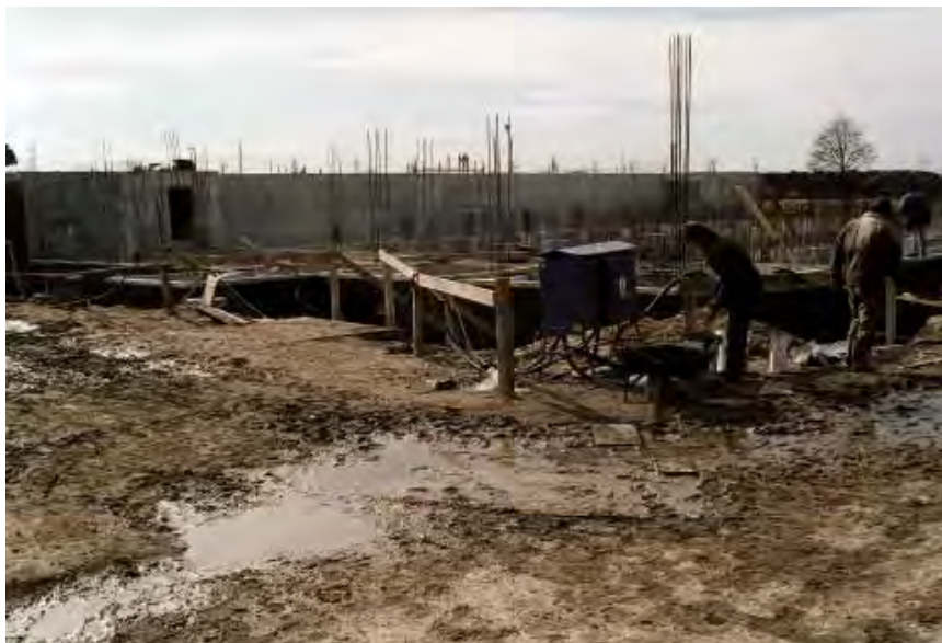
Fundamenty Kompleksu Nauk Biologicznych; kwiecień 2000
