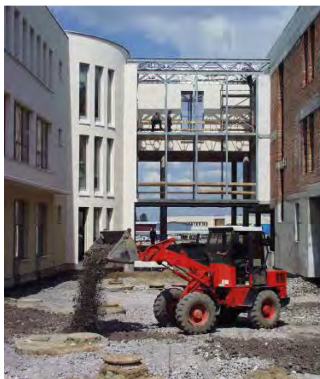
Budowa Kompleksu Nauk Biologicznych; czerwiec 2001
